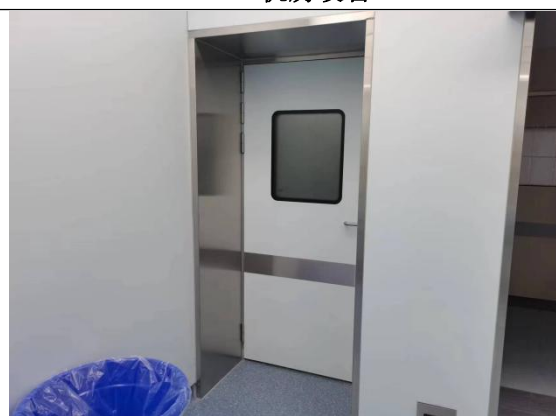
DSA 机房废物通道门
