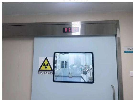
DSA 机房病人防护门
